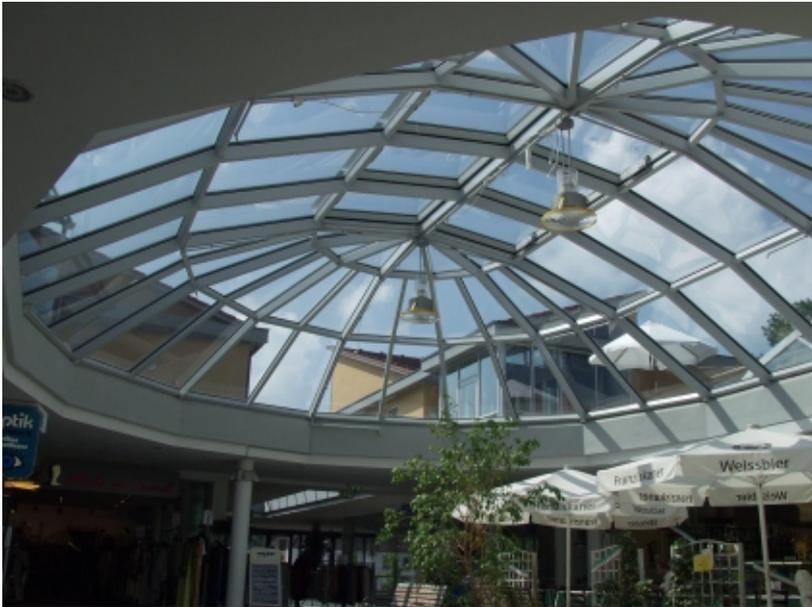
Stahl- Glasdach Polygonal mit RWA - Klappen
